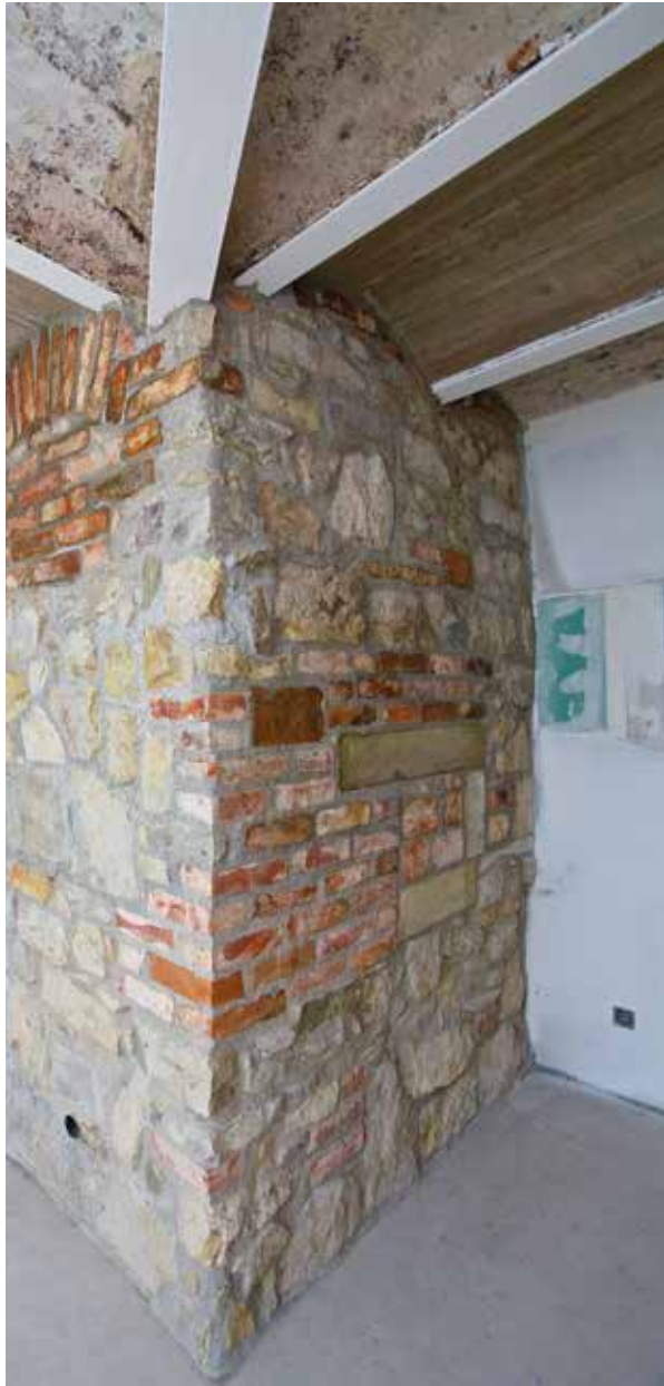
Der Erhalt dieser Industriedecke war ein wesentlicher Bestandteil des Bauvorhabens.
