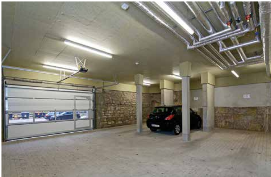
Nach mehreren Tonnen Erdaushub wurde auch Platz für eine Tiefgarage geschaffen.
