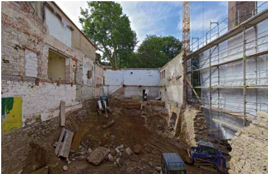
Aufwendige Abbruch- und Endkernungsarbeiten unter Beachtung der Statik und des Denkmalschutzes.
