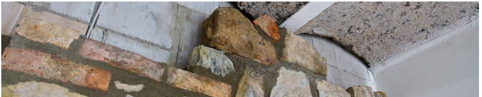
Mit Liebe zum Detail wurde die alte Mauer denkmalgerecht in den Wohnraum integriert.
