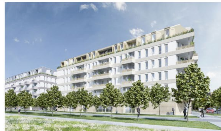
Kötzschenbrodaer Straße Dresden-Mickten (Neubau)
